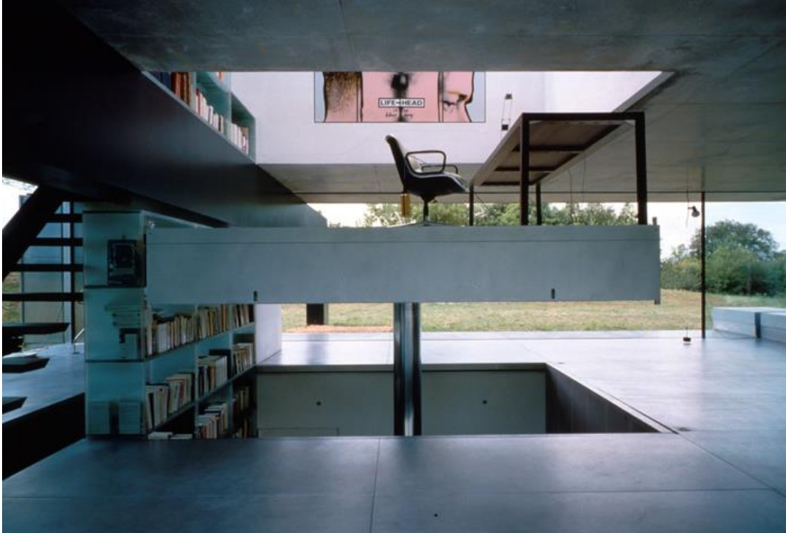
Figura 8: Plataforma elevatória. Maison Bordeaux. Fonte: http://oma.eu/projects/maison-a-bordeaux
